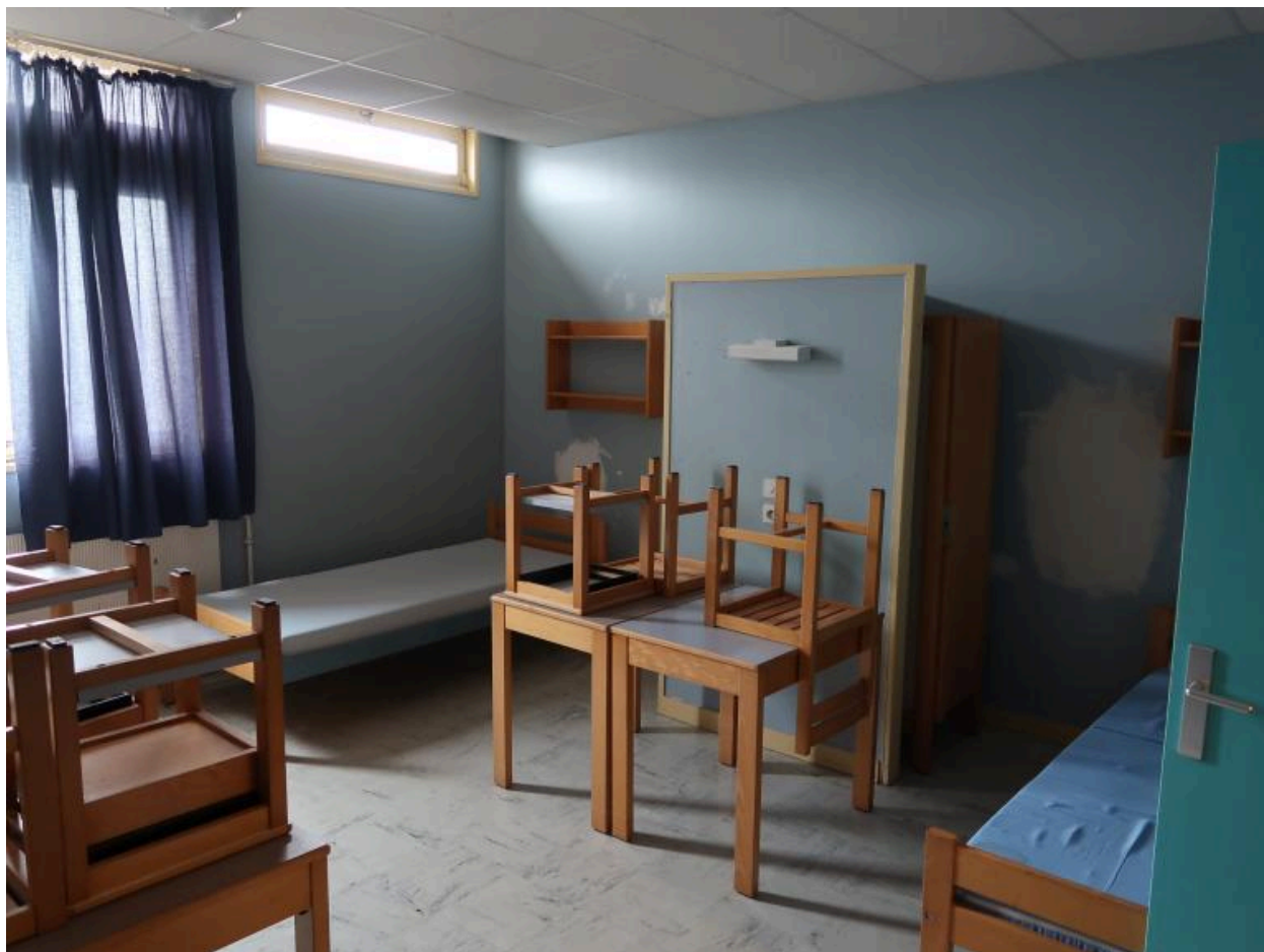
Internat désaffecté : une chambre après la réhabilitation de 1991.
