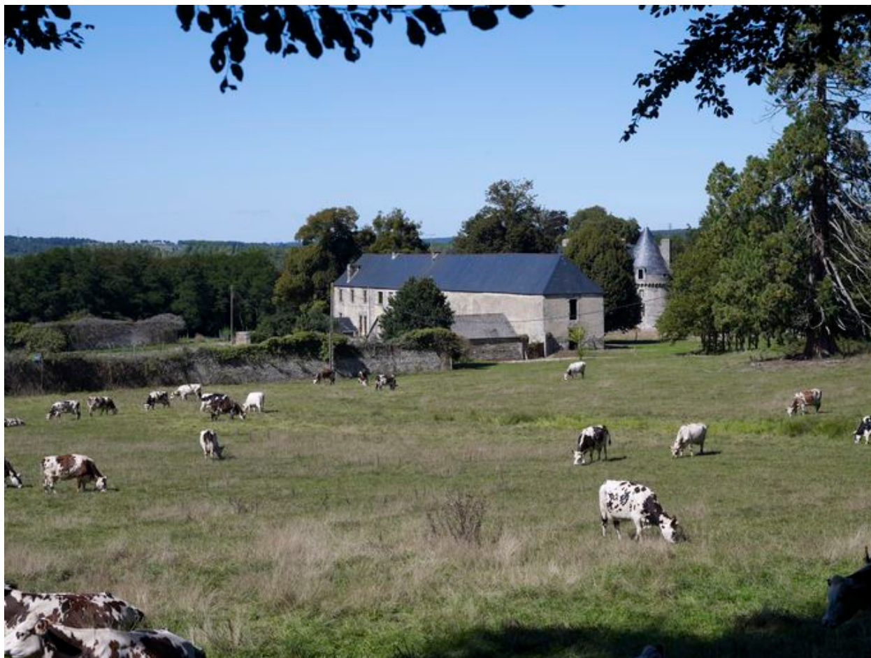
Château, dépendance ouest et tour sud-est : vue générale prise du sud-ouest (état en 2010)
