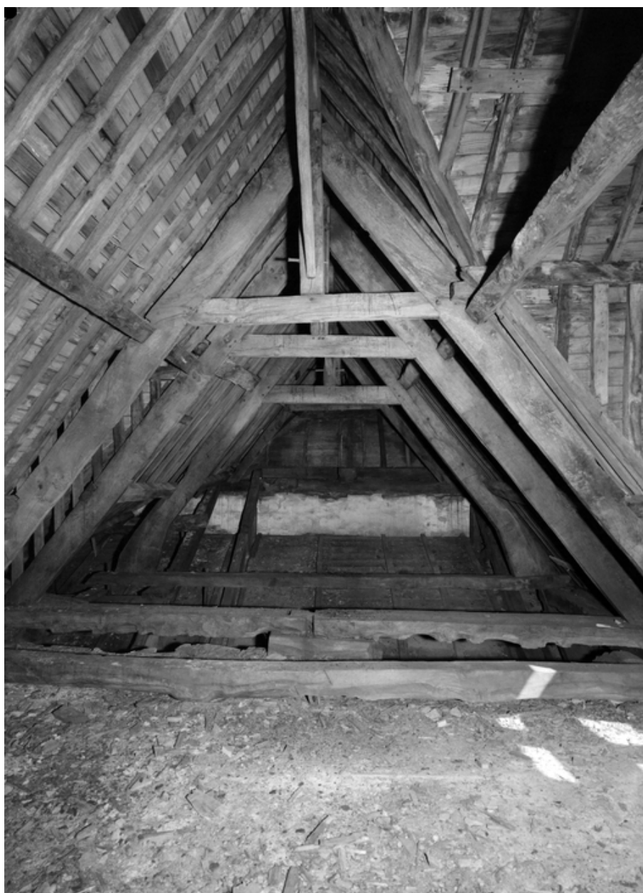
Porche sud, charpente
