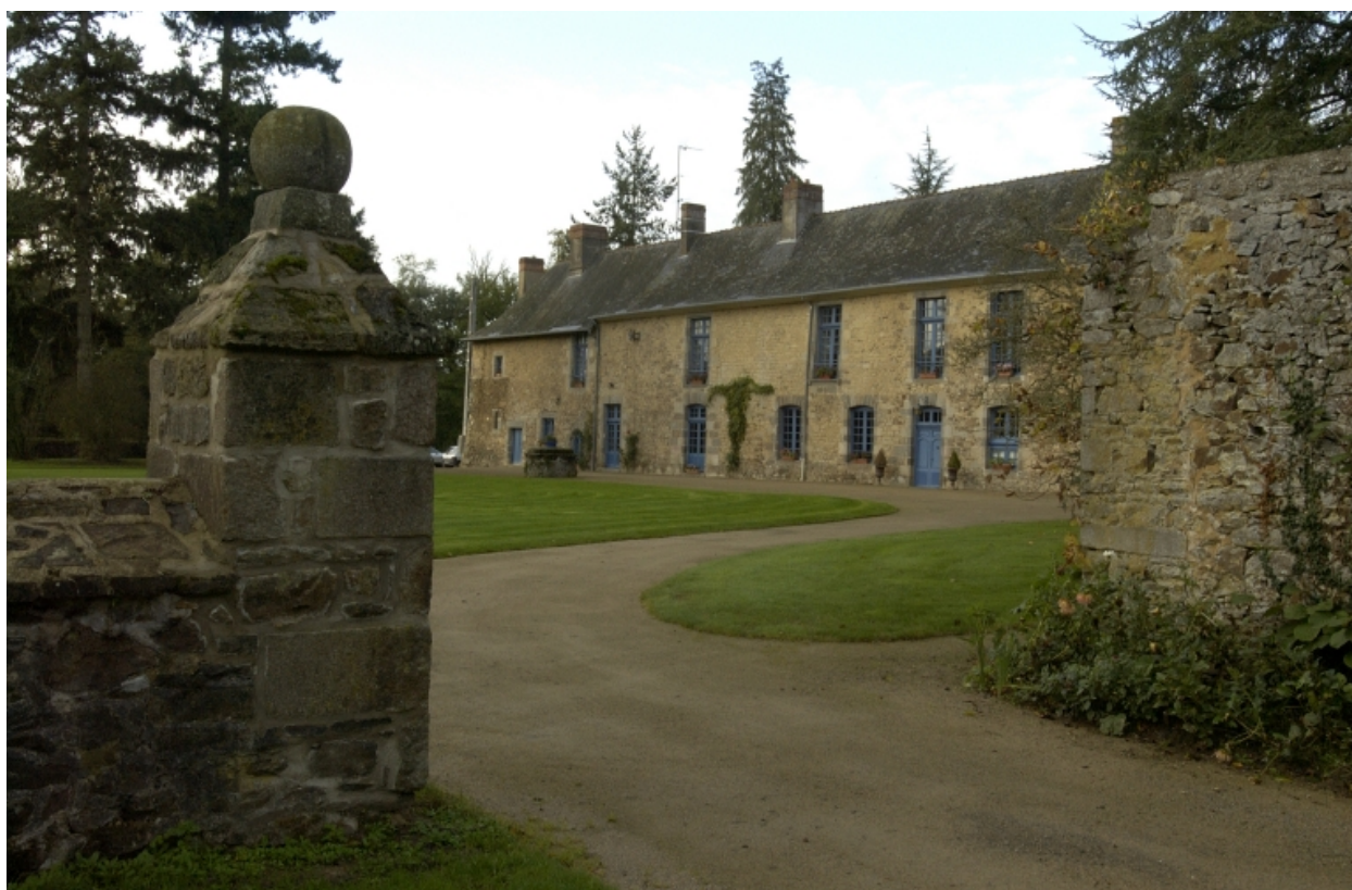
Vue du château depuis le portail
