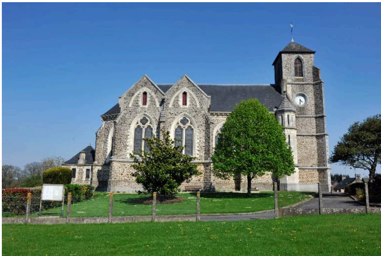
Vue générale : côté Ouest
