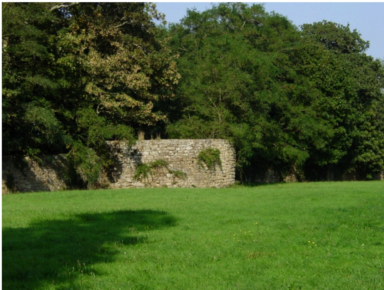
Clôture du parc. La tour belvédère, à l'est du portail, vue générale sud-ouest.
