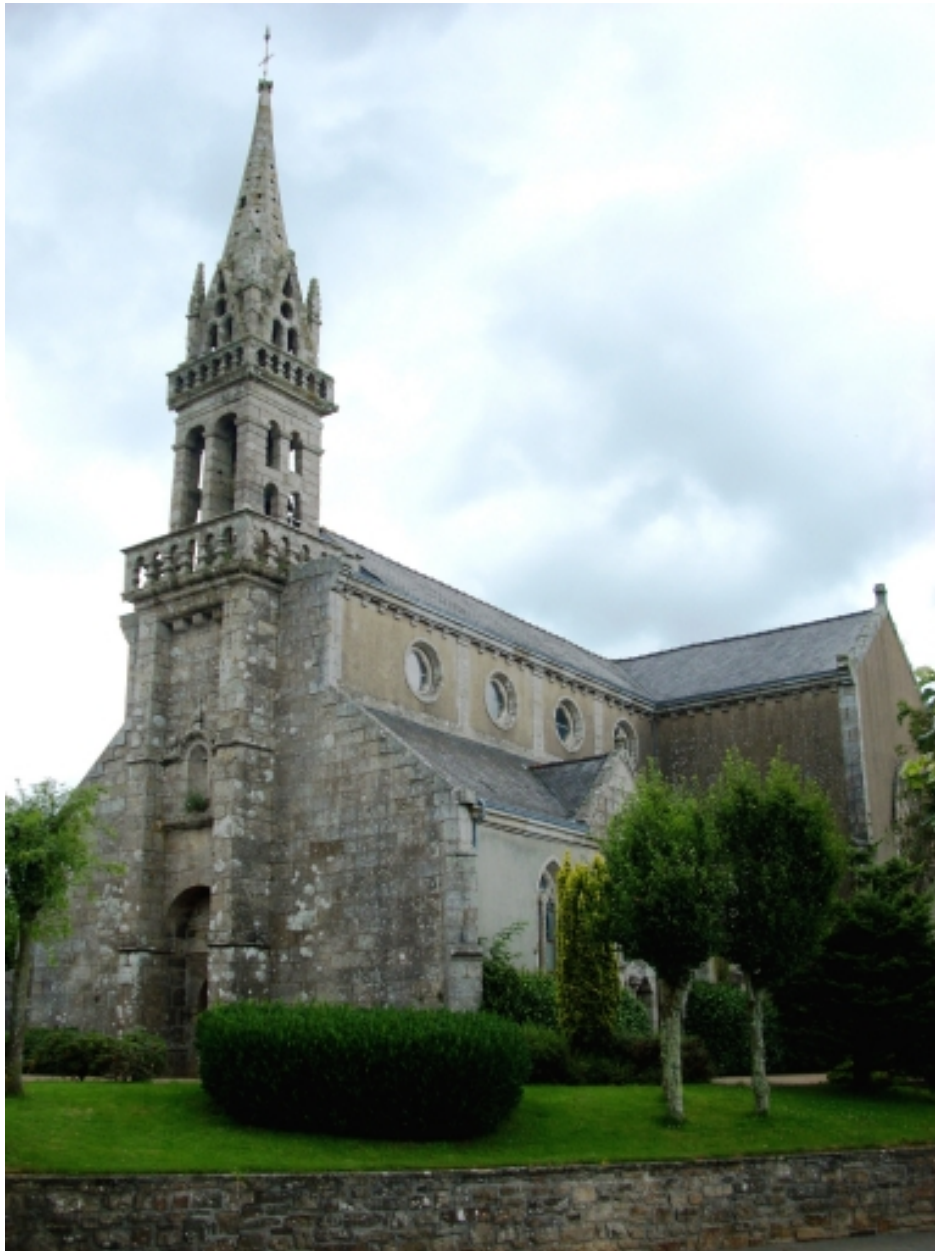
Botsorhel, église paroissiale Saint-Georges : vue générale sud-ouest
