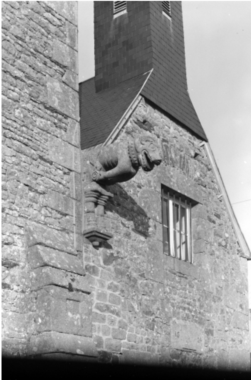
Façade sud, sacristie détail crossette.
