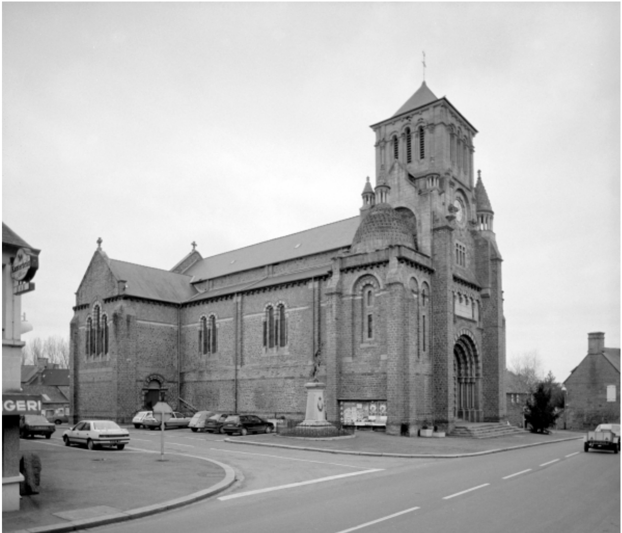
Élévation Nord-Est : vue générale
