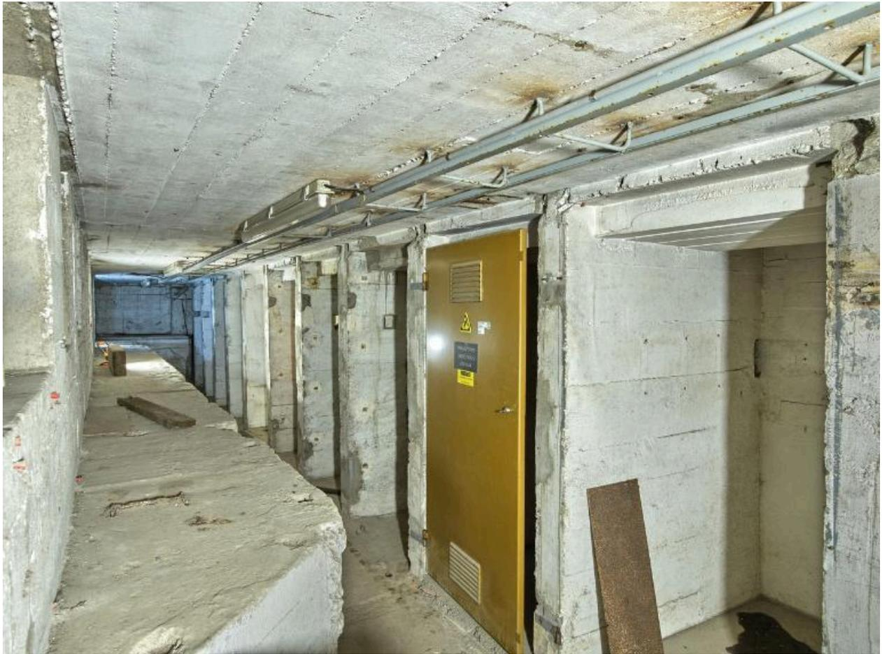
Locaux techniques, partie sud, en demi-sous-sol : cellules pour transformateur électrique.
