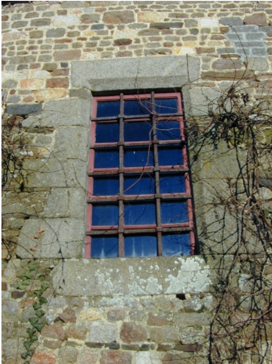
Longère sud, fenêtre de la nef : vue générale
