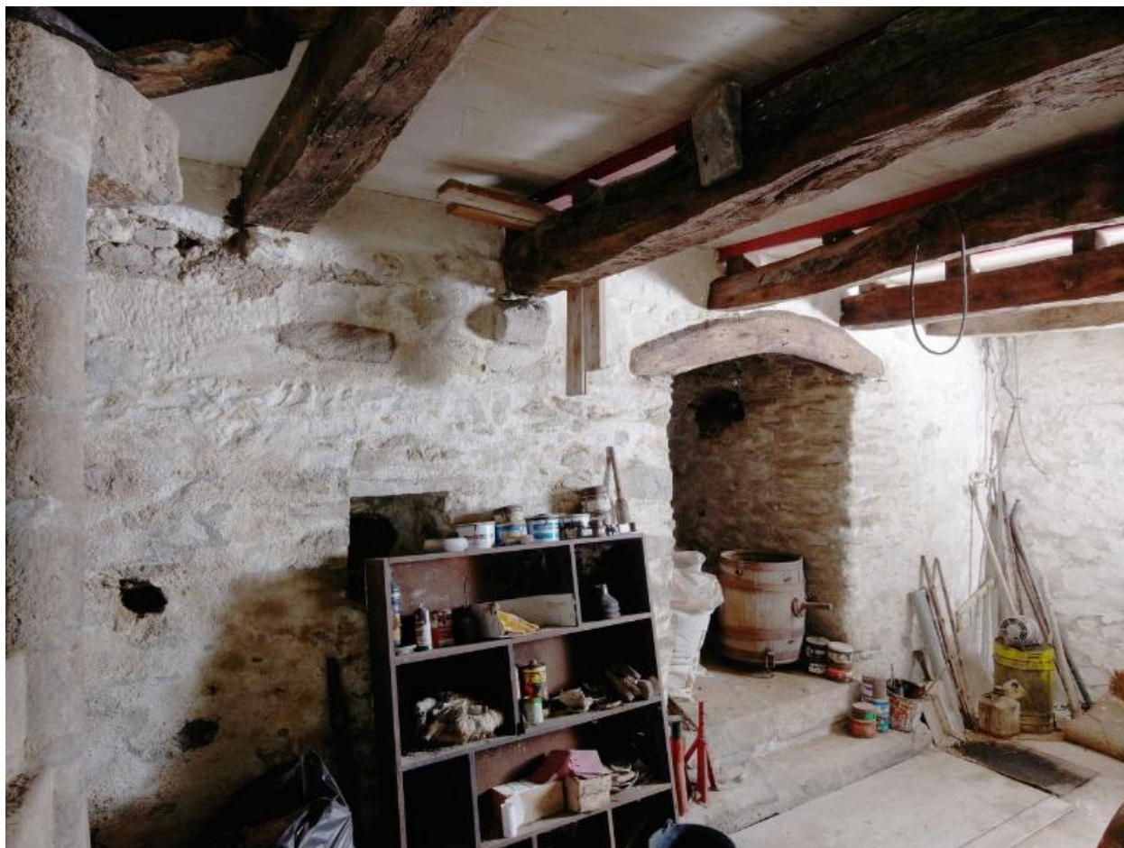
Sous-sol avec renforcement. Vue générale
