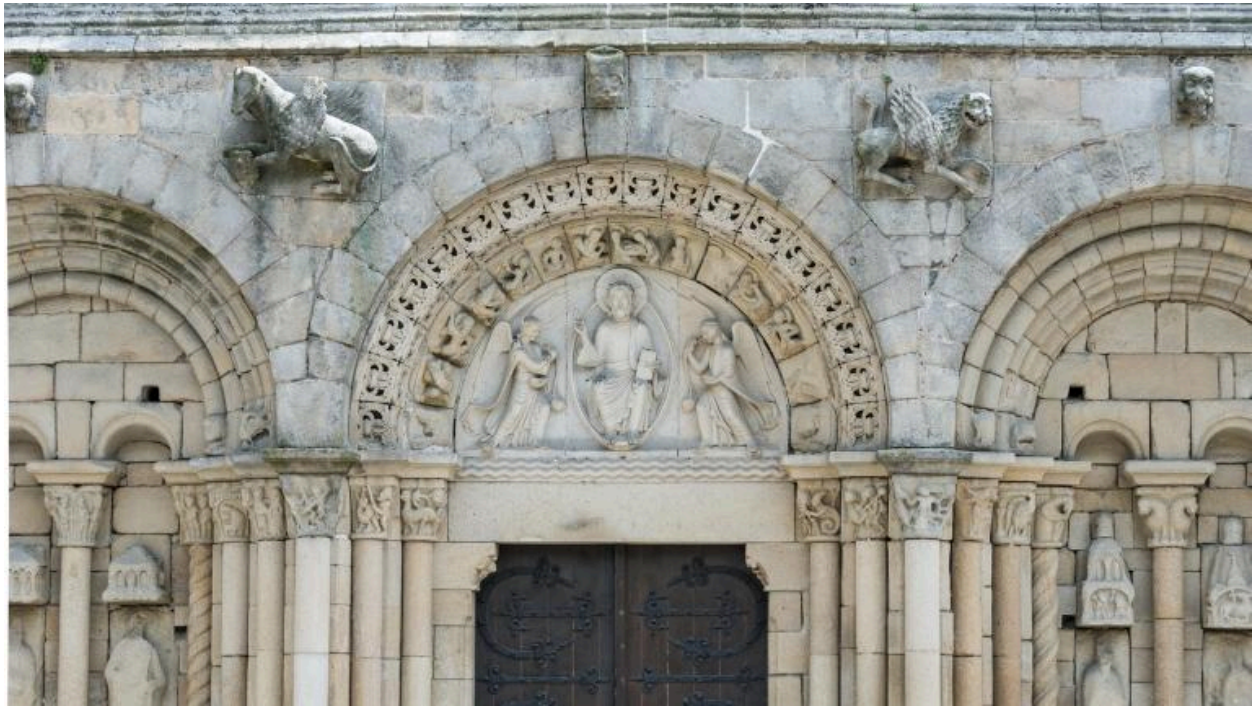
Vue partielle premier niveau de la façade ouest
