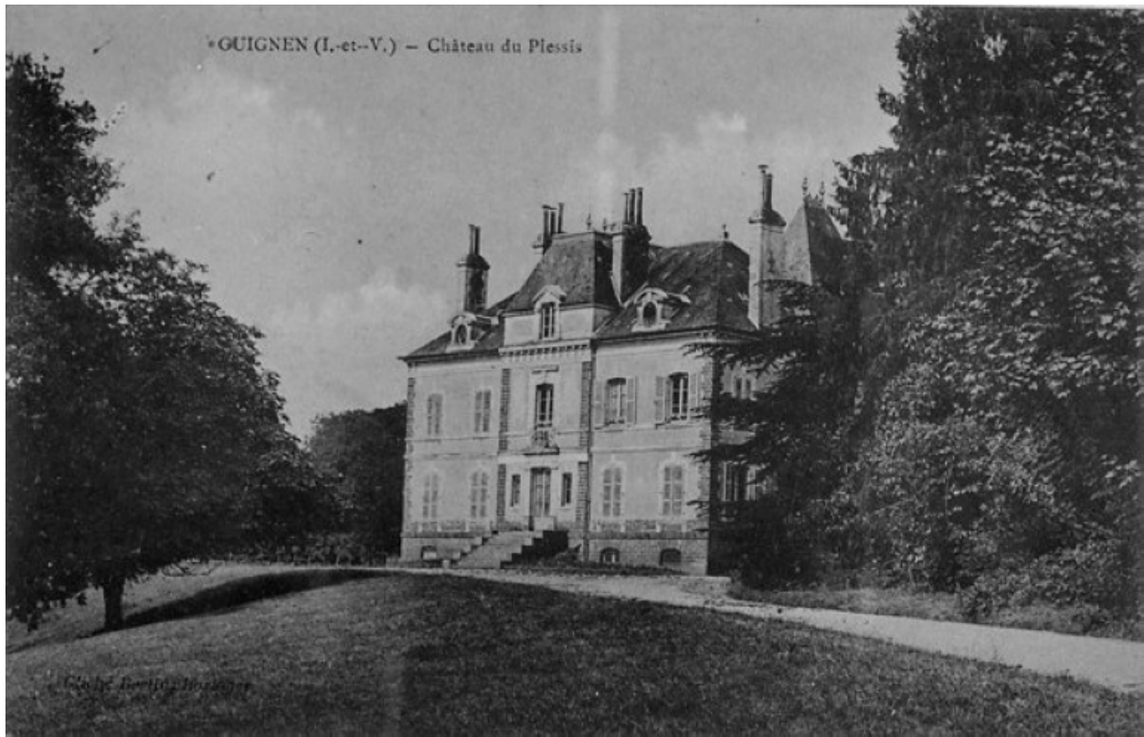
Vue générale sur la façade principale
