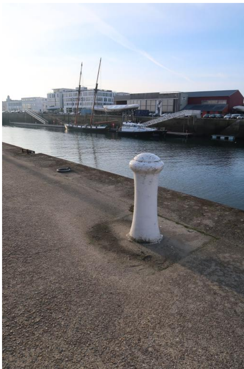
1er éperon, quai ouest, bite d'amarrage (fonte)
