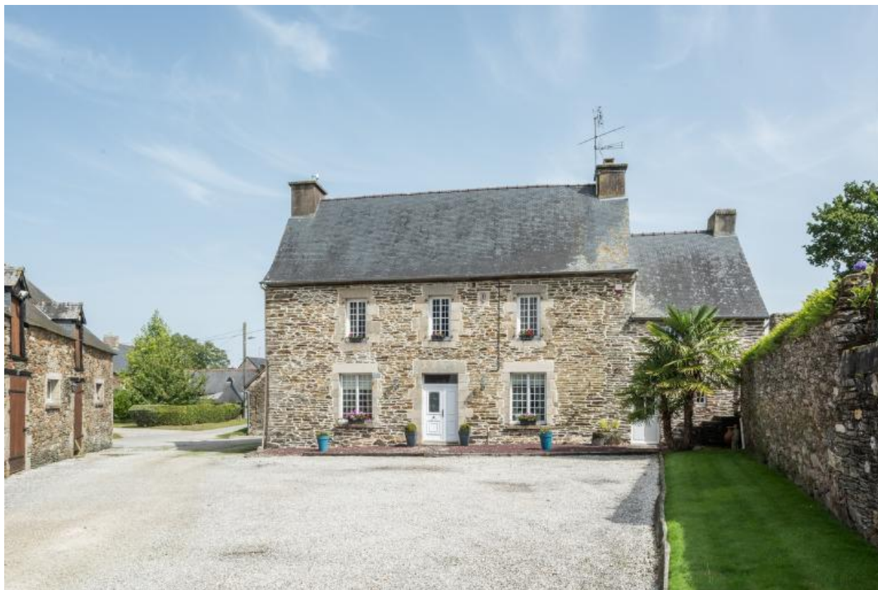
Logis, cour et mur de séparation avec le presbytère. Vue générale depuis l'ouest
