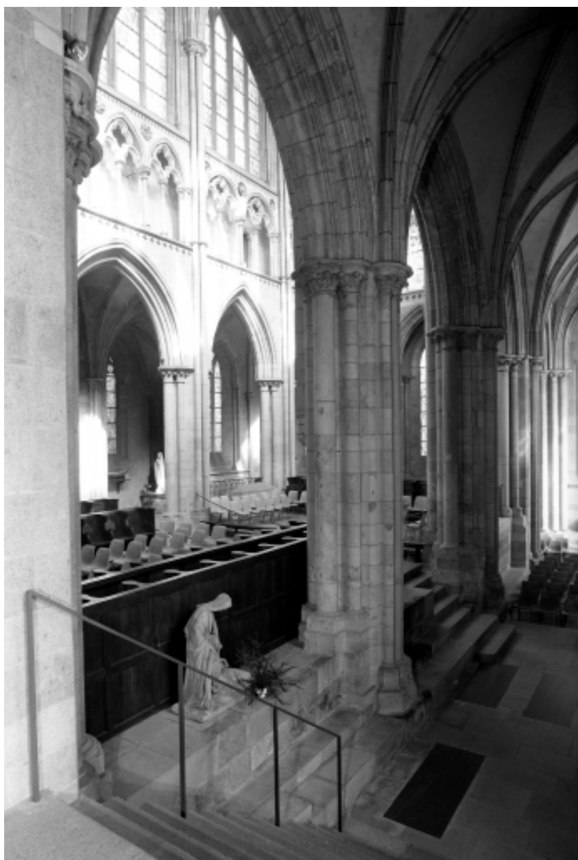
Intérieur, abside, travée Sud : vue générale
