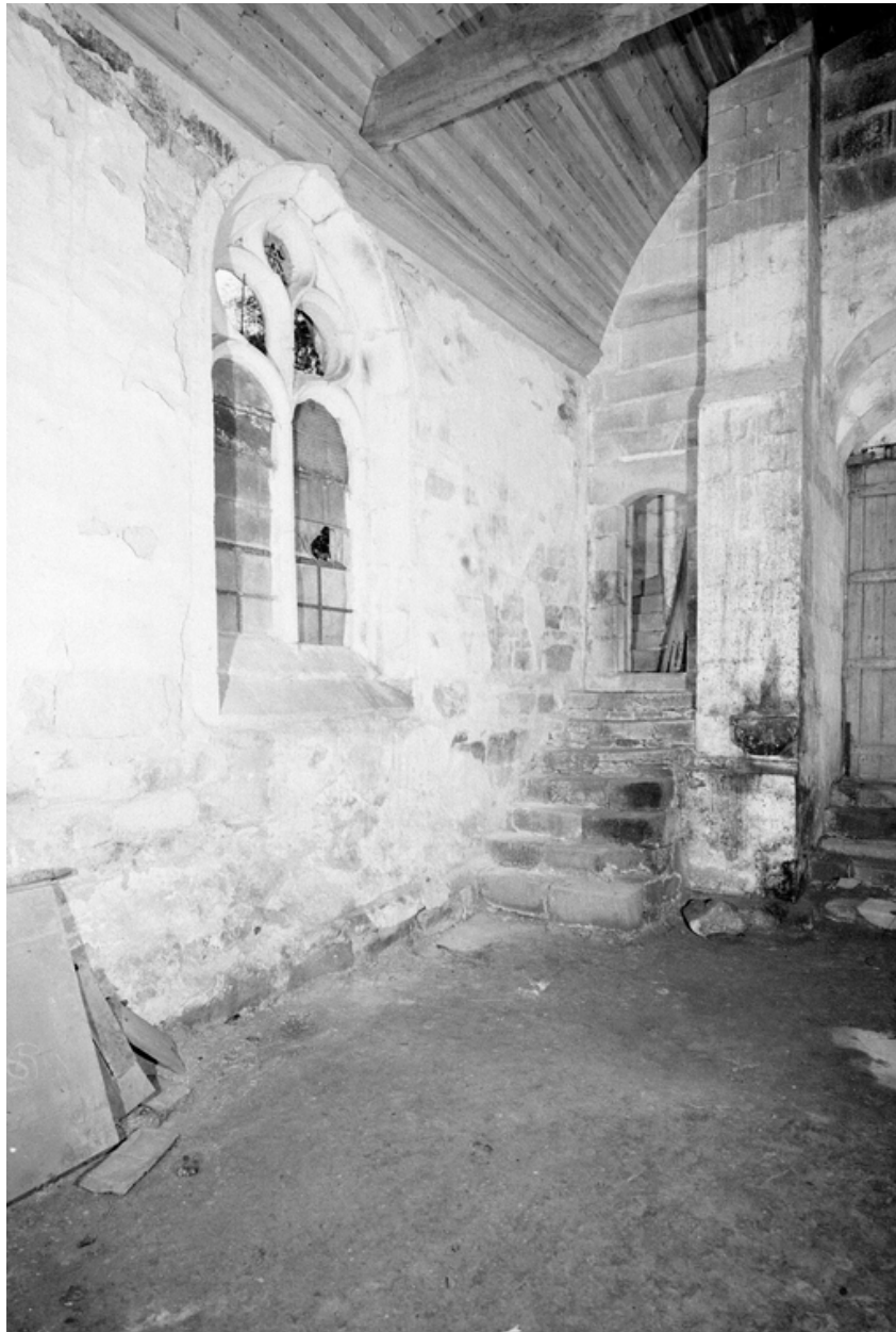
Vue de l'angle sud-ouest de la nef
