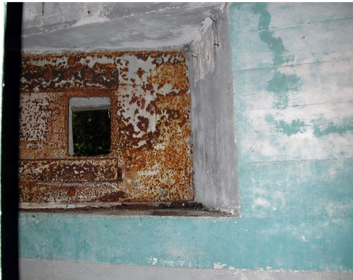
Vue de la salle de garde : créneau blindé permettant de défendre l'entrée (état en 2002)
