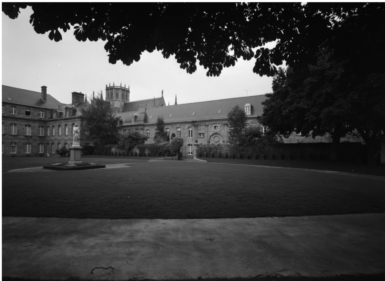
Vue générale, en diagonal (1974)
