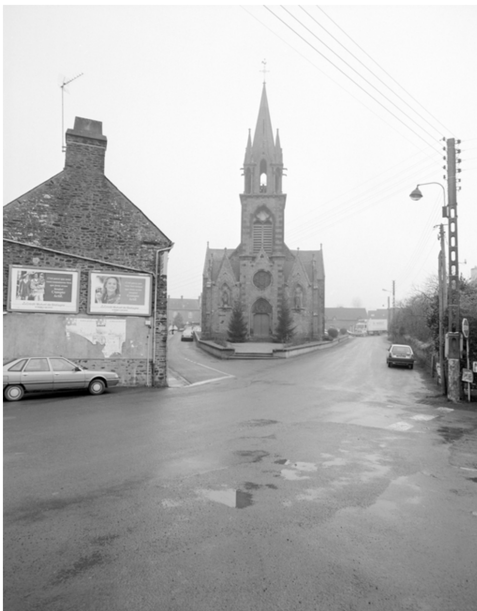
Elévation Ouest : vue générale.
