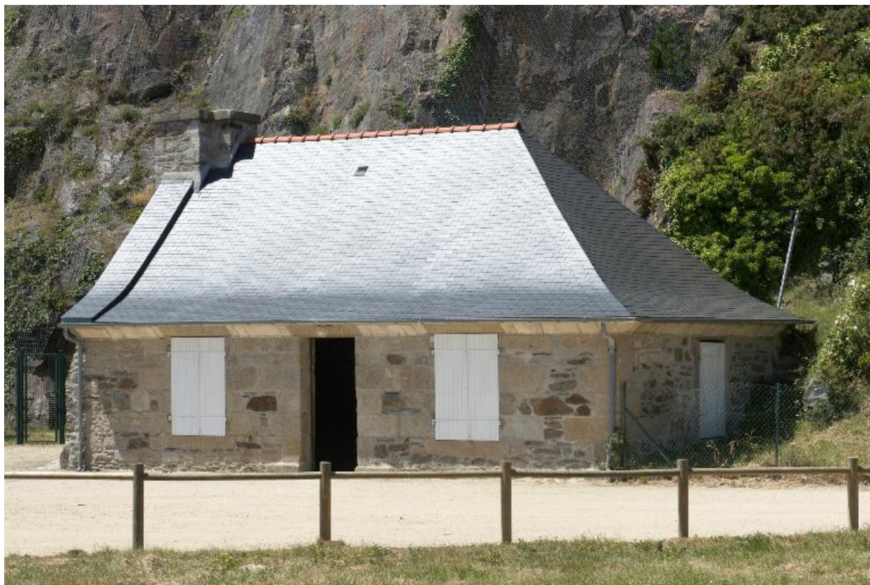
Plouzané : vue du fort du Mengant, corps de garde
