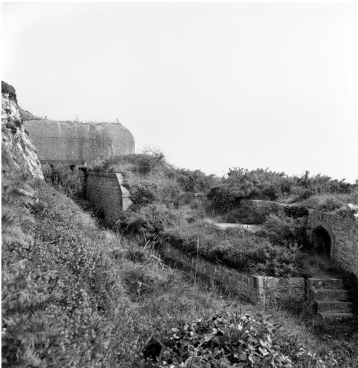
Vue de la batterie de côte du Petit Gouin en 1969. La batterie basse a été augmentée d'un bunker - casemate de type 671 coiffant le débouché du magasin à poudre sous roc
