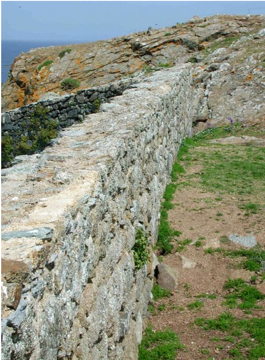
Vue de détail du demi-bastion nord (état en 2002)
