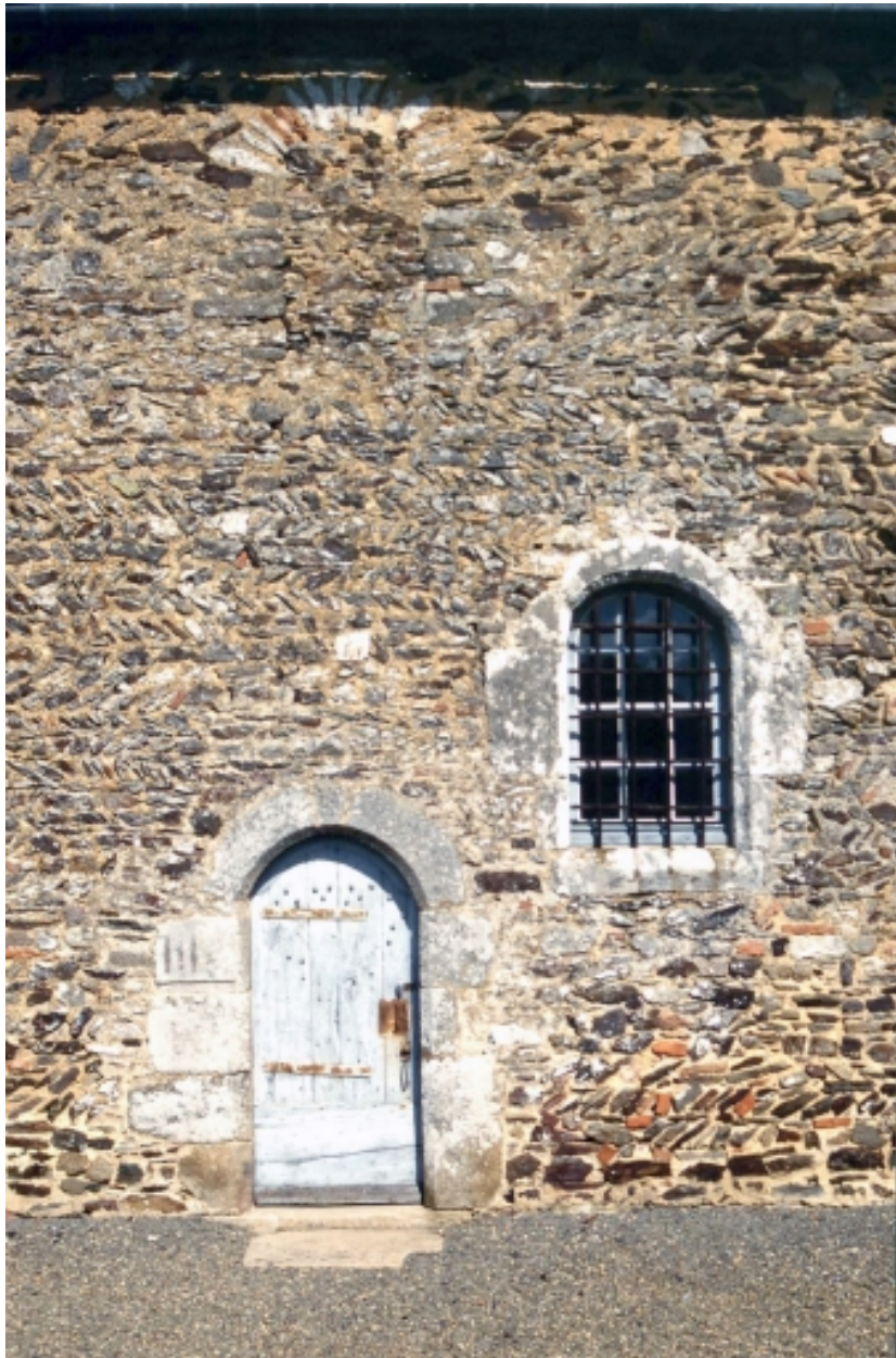
Elévation sud : détail porte.
