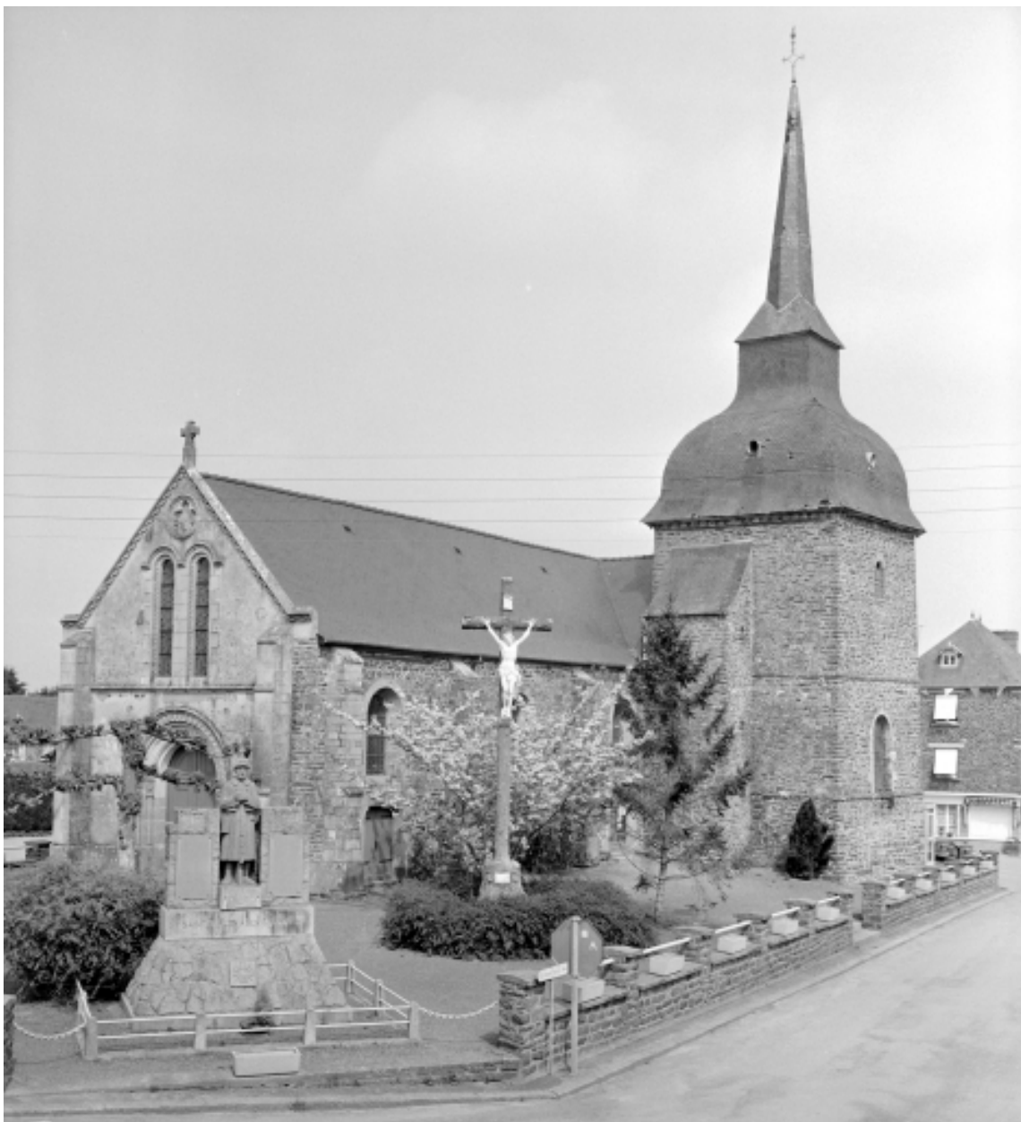
Elévation Sud-Ouest : vue générale
