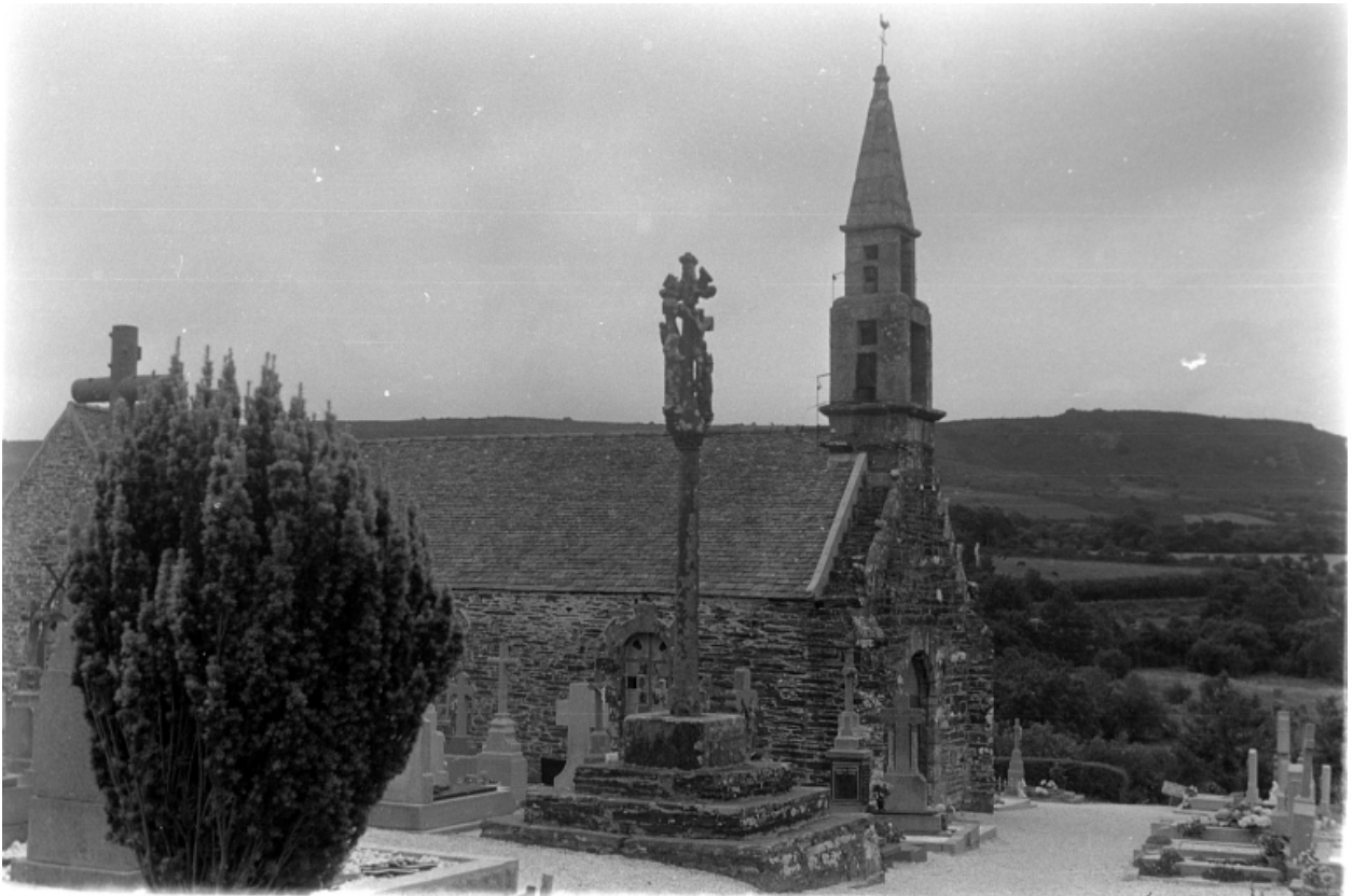
Saint-Rivoal, église paroissiale Saint-Rivoal : Vue générale nord. Etat en 1969
