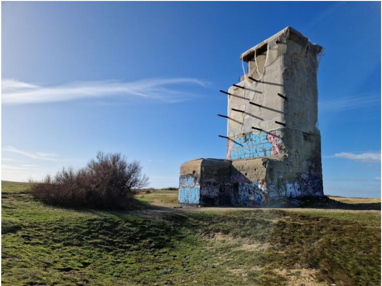
Vue générale du bunker - poste de direction de tir depuis l'est
