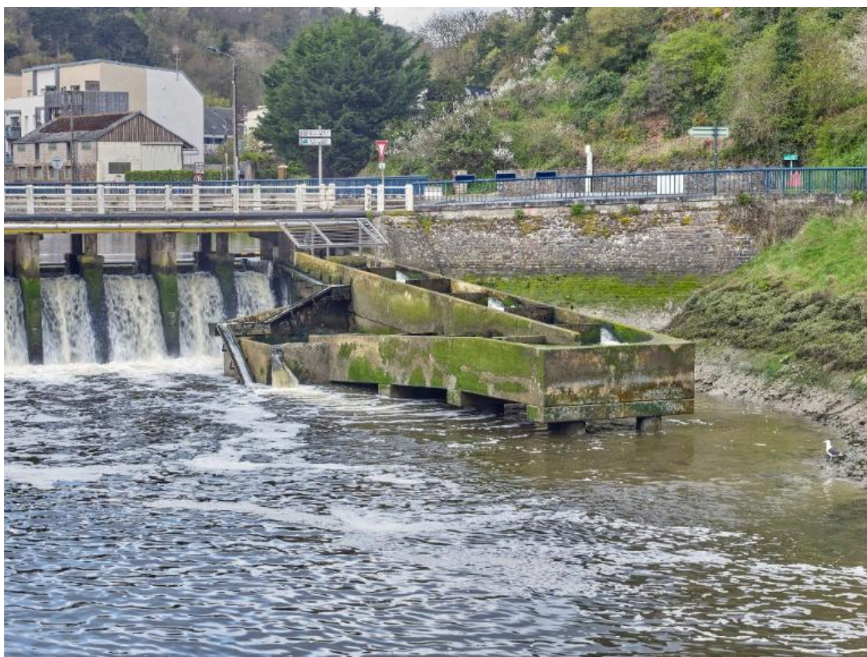
Vue de la passe à poissons sur le déversoir
