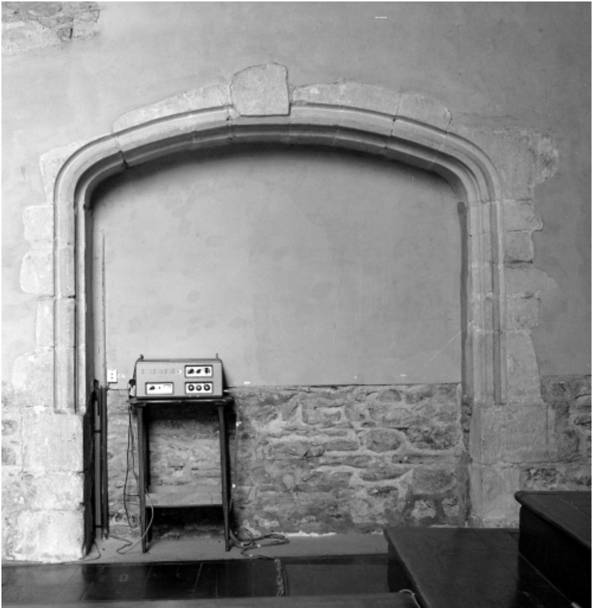
Choeur, mur sud, détail de la niche crédence.
