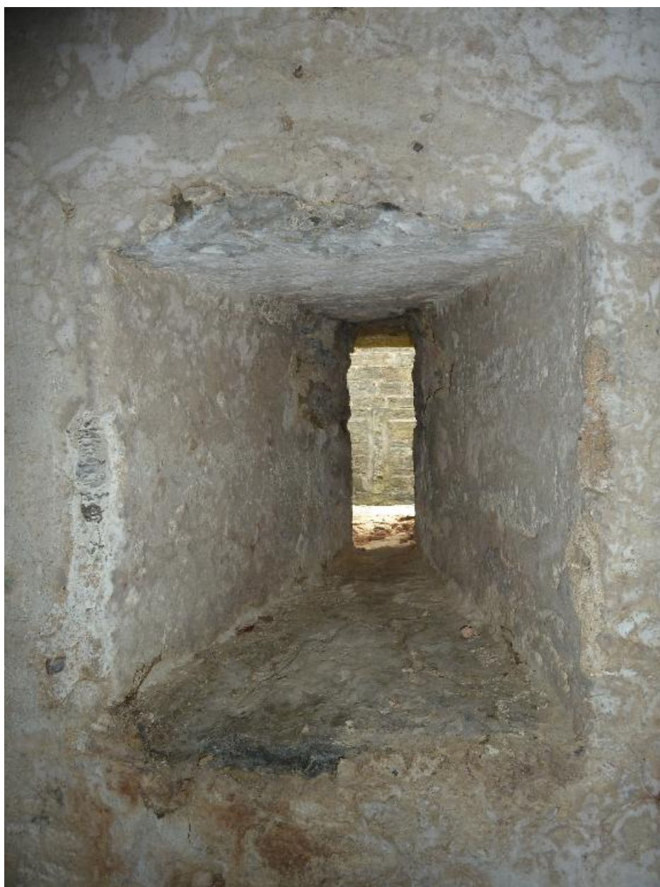
Le Palais, enceinte urbaine, réduit B, créneau de tir.
