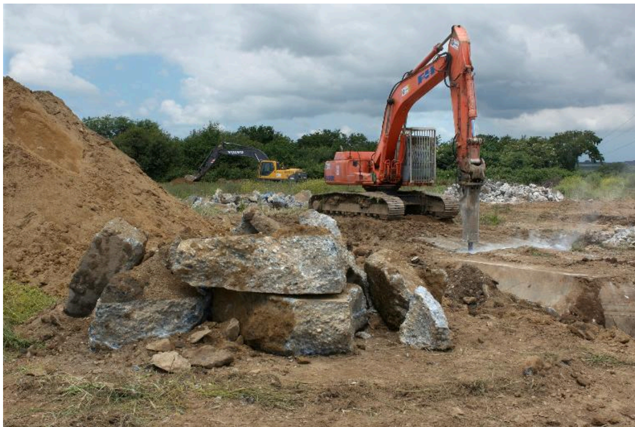
Déconstruction d'un bunker de type 502
