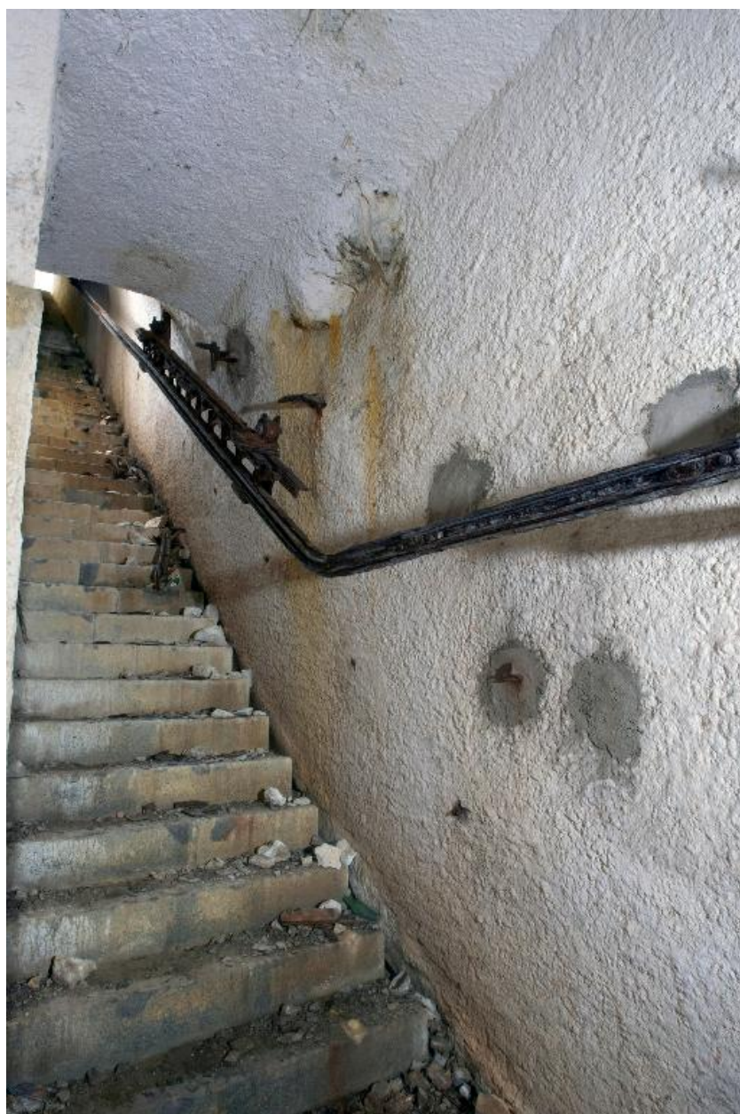
Camaret, pointe du Toulinguet : magasin à poudre sous roc (construction vers 1892), escalier d'accès et monorail élévateur
