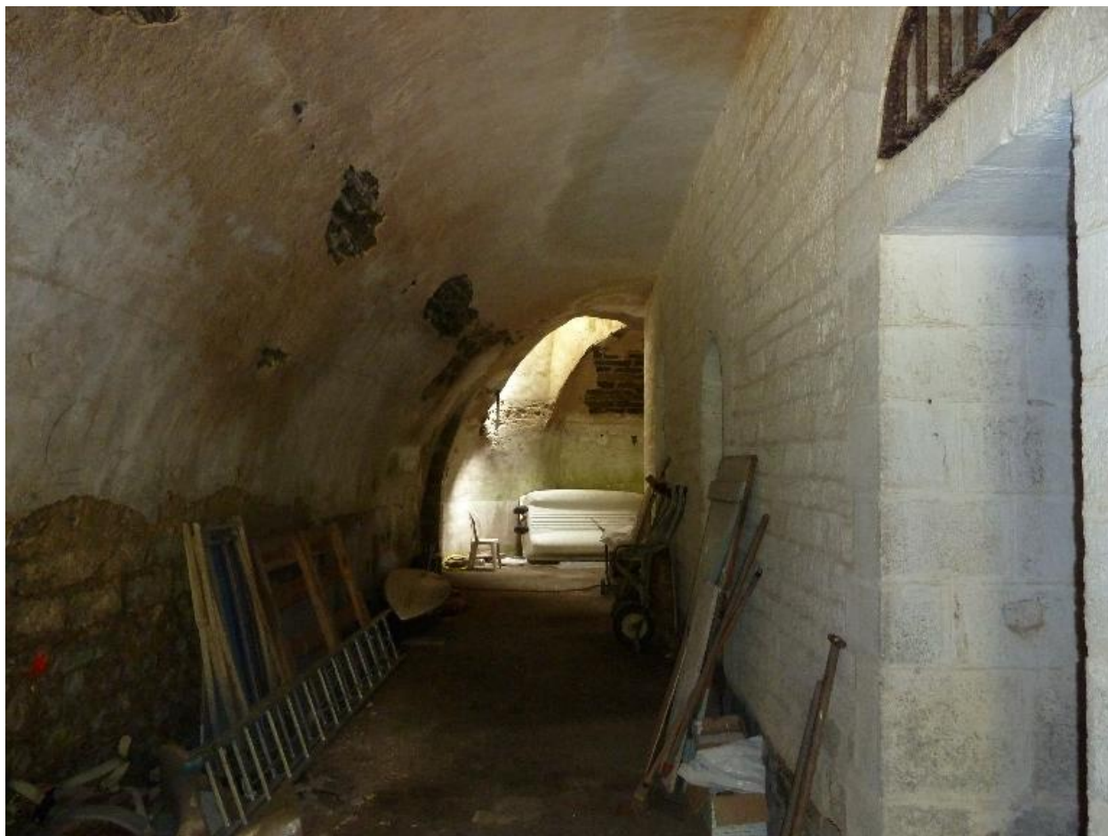
Le Palais, batterie du Gros Rocher, corps de garde crénelé, façade nord.
