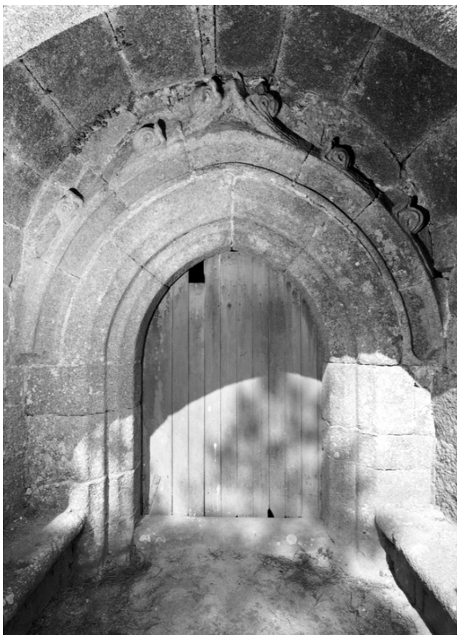
Porche ouest : porte du mur est
