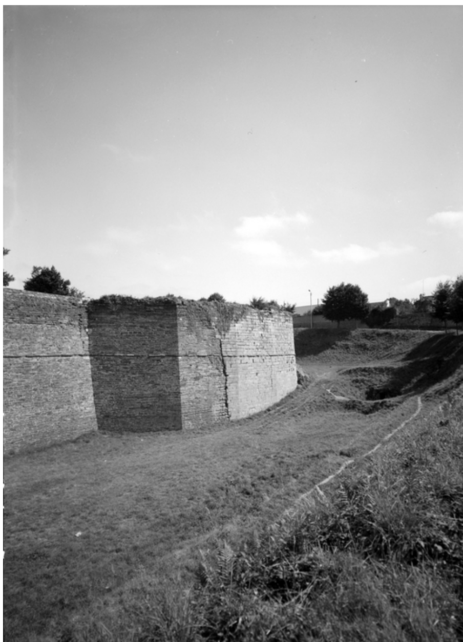
Bastion sud-est vu du sud-ouest.
