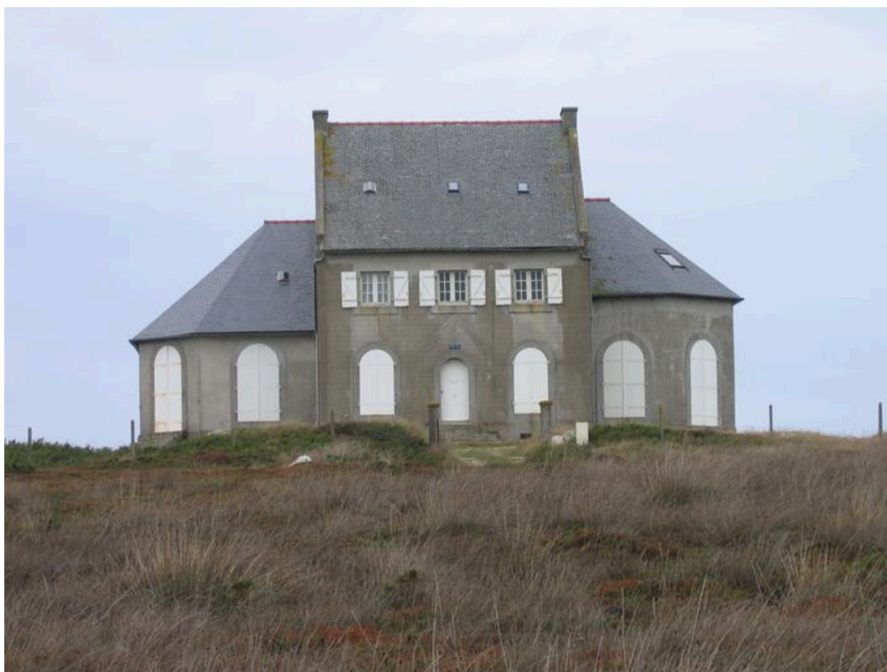
Vue côté terre de la première villa d'André Antoine dite l'Armor Braz
