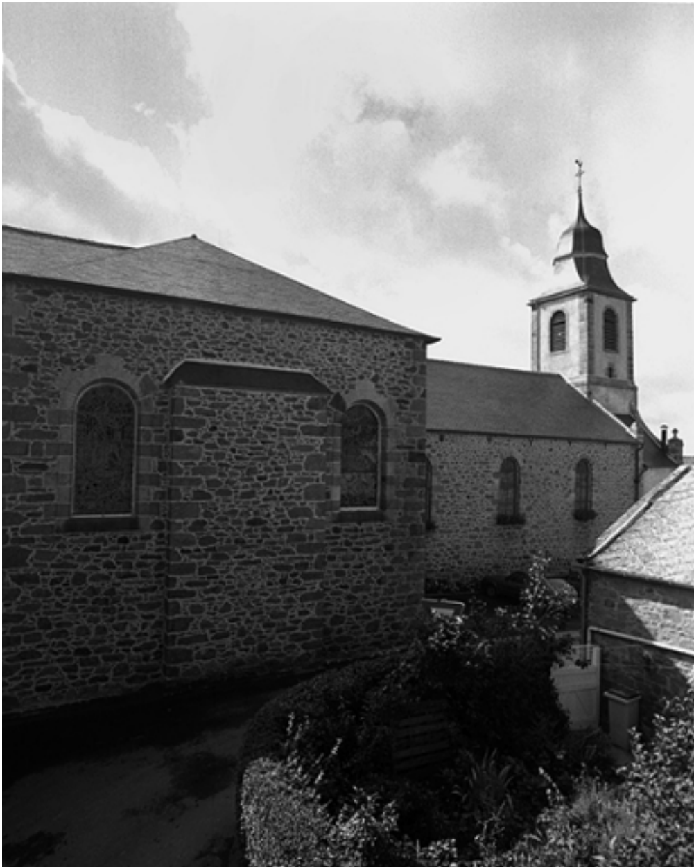
Elévation nord : vue générale
