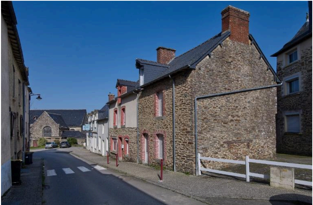
Alignement de maisons de la rue du Vieux Bourg
