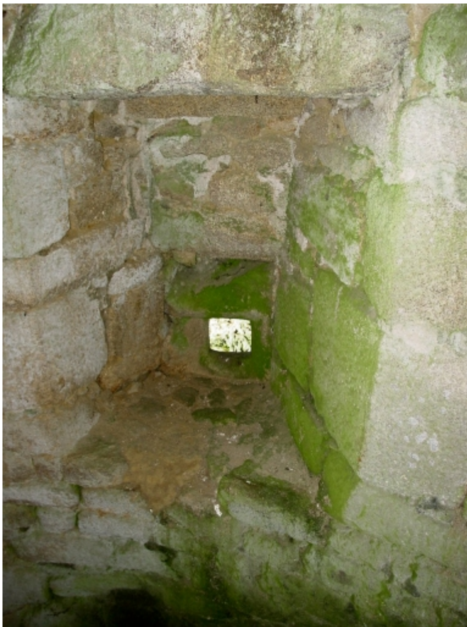
Ancien logis, tour d'escalier sud-ouest : bouche à feu de forme quadrangulaire, vue intérieure.
