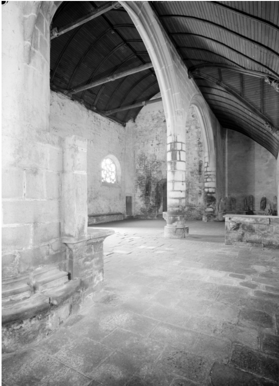
Vue générale vers l'ouest prise du bas-côté sud.
