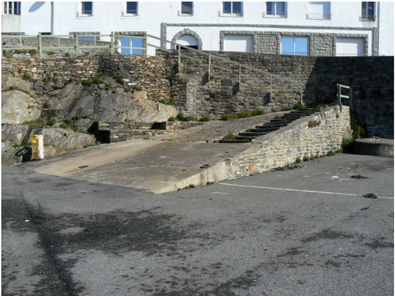
Escalier permettant d'accéder à la cale Cayenne
