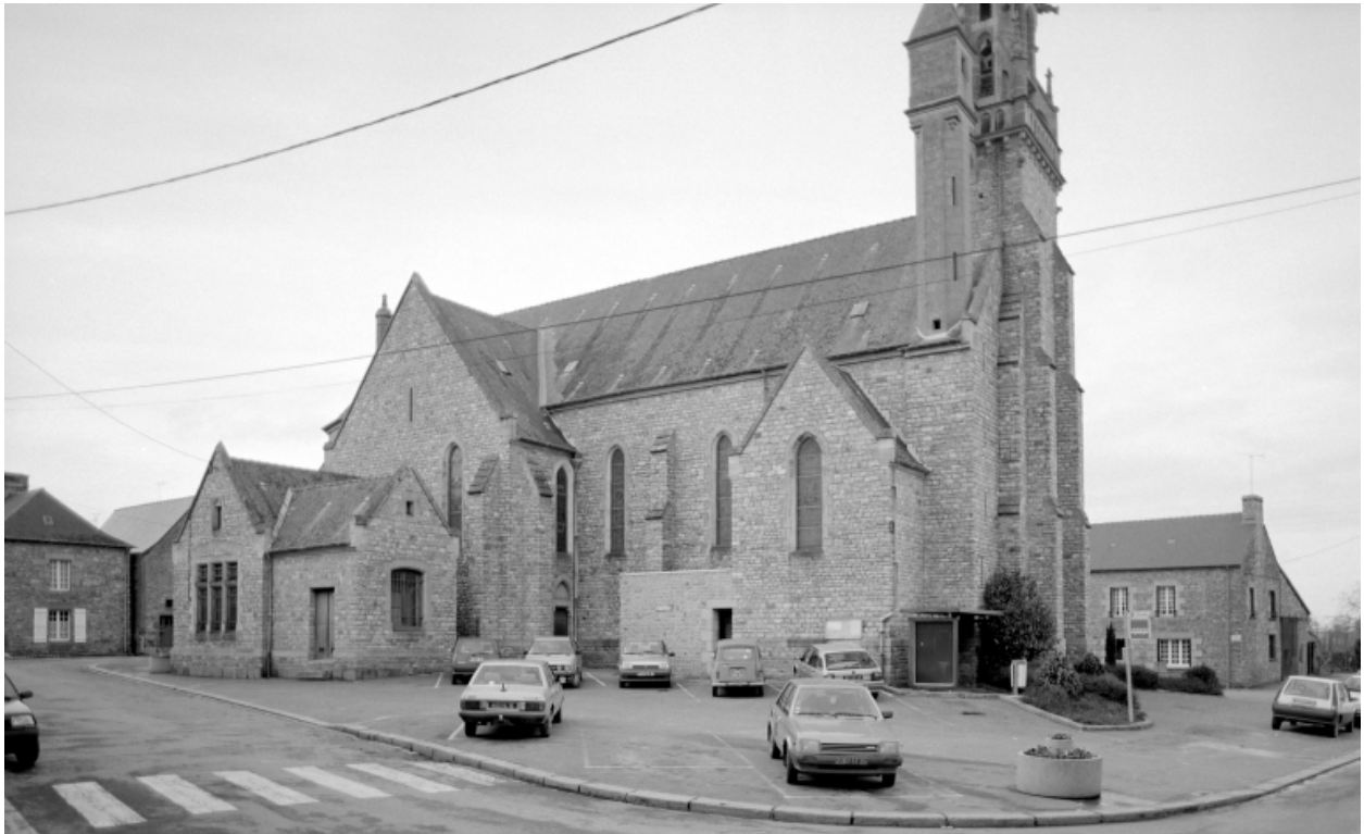
Elévation Nord : vue générale
