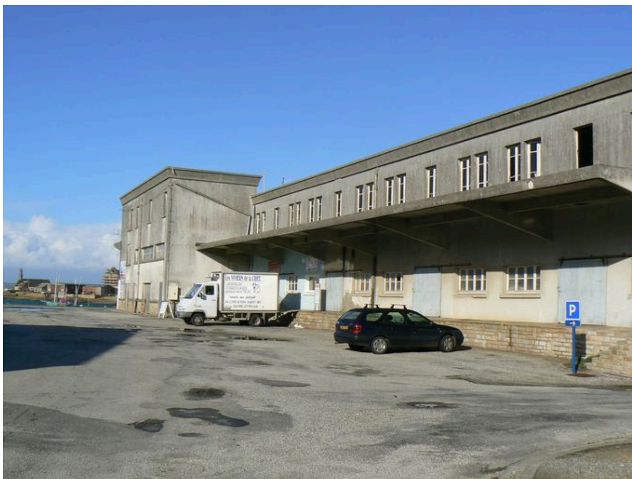
Elévation postérieure de la criée de Camaret
