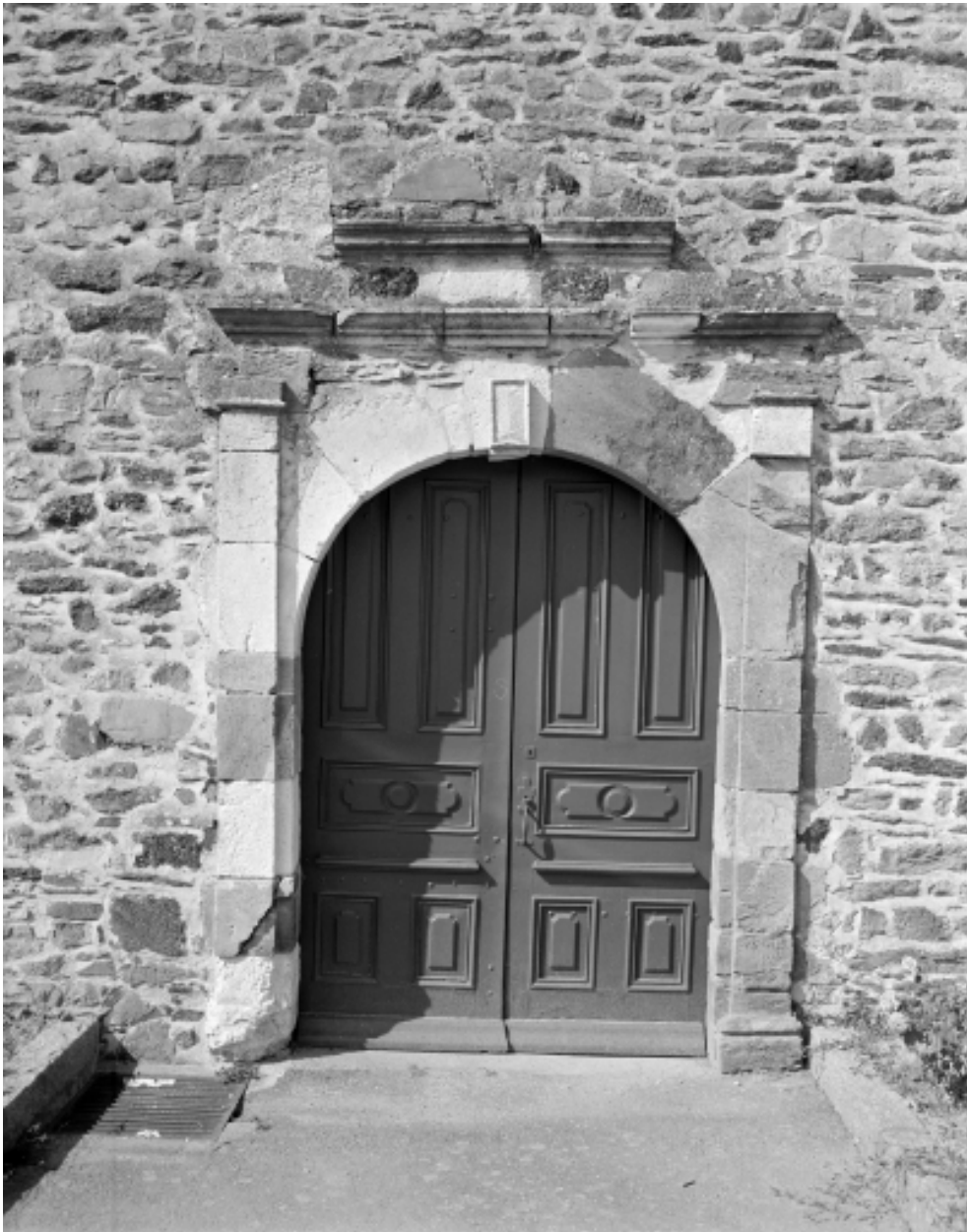
Elévation sud, porte ouest : vue générale
