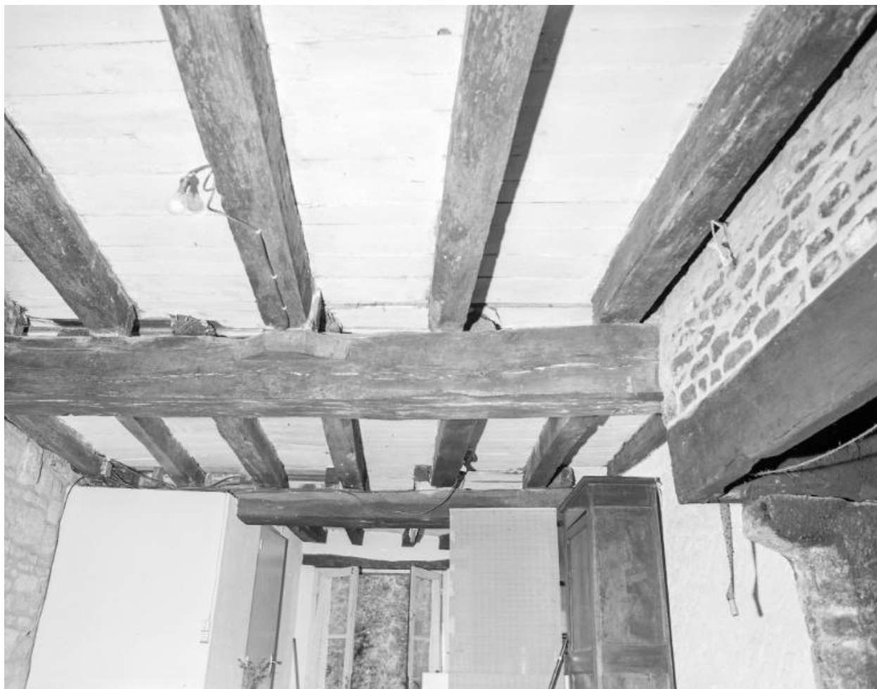
Disposition des solives et poutres à l'étage (1978).
