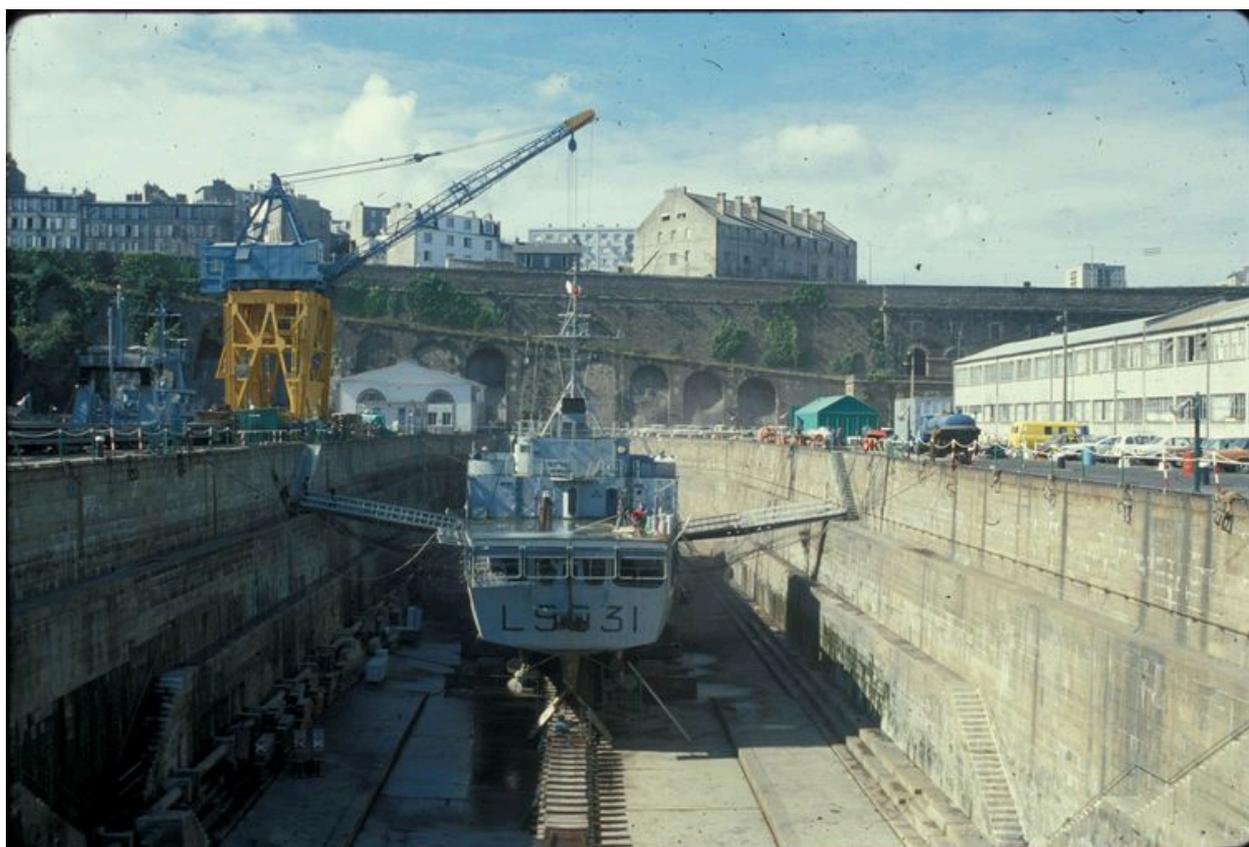
Vue de l'arsenal de Brest en 1980 : un navire dans la forme de construction, bassin de radoub nord de Pontaniou dit forme de Pontaniou. En arrière-plan : la levée de Pontaniou et le bâtiment aux Lions
