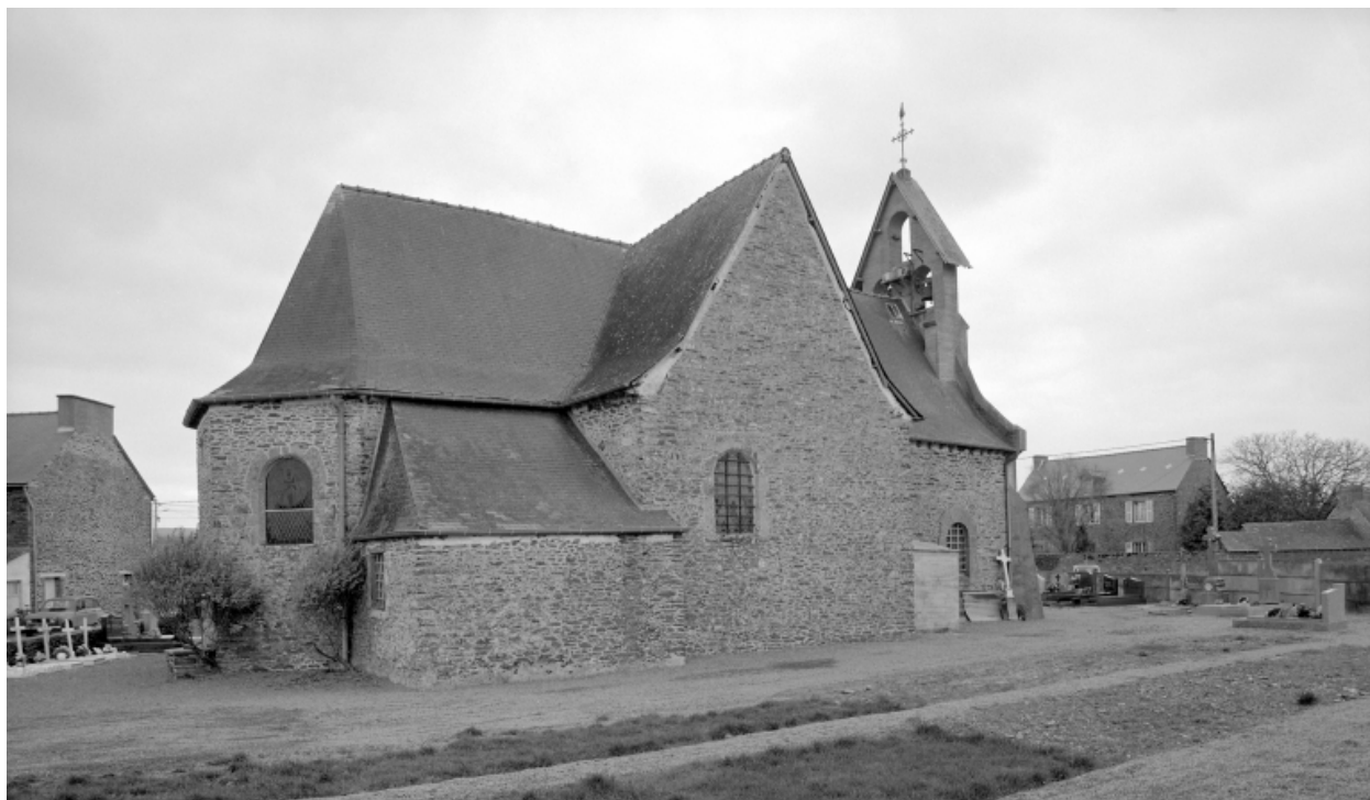
Elévation Nord : vue générale
