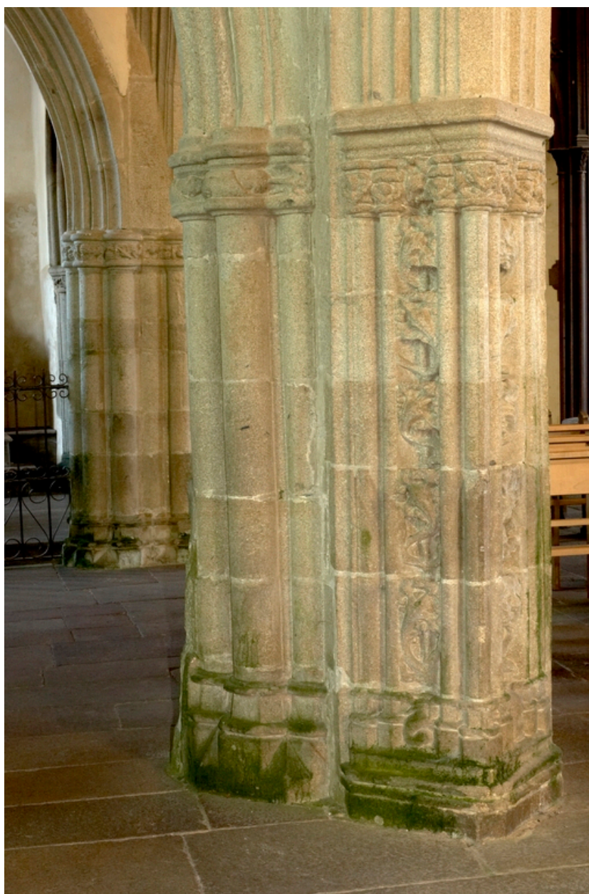
Pile ouest de la chapelle de la commanderie
