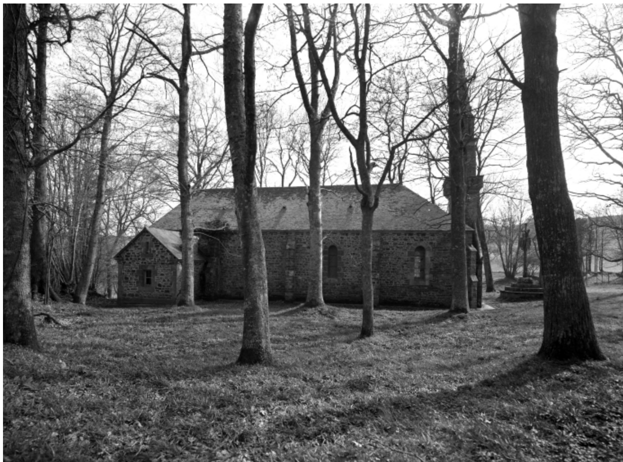
Vue générale nord. Etat en 1968
